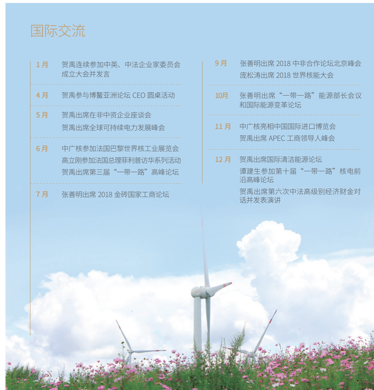
勐海帕顶梁子风电场
