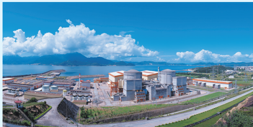
1994 年建成投产的大亚湾核电站
