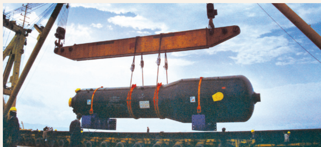
1990年6月15日，由法国法马通公司生产的大亚湾核电站1号机组核岛蒸汽发生器到达大亚湾核电站材料码头。
